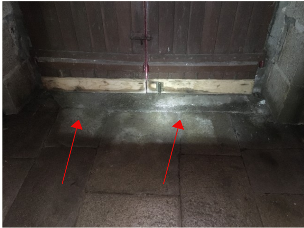
P02 - Humidité seuil de porte, entrées d'eau
