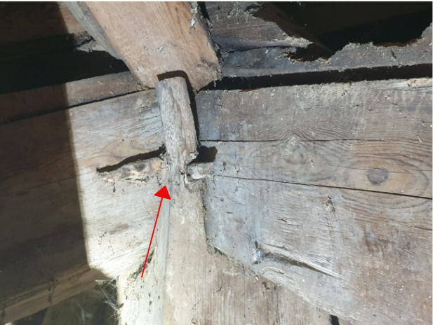
Croisée - Éclatement du poinçon, concentration des bois dans l'assemblage
