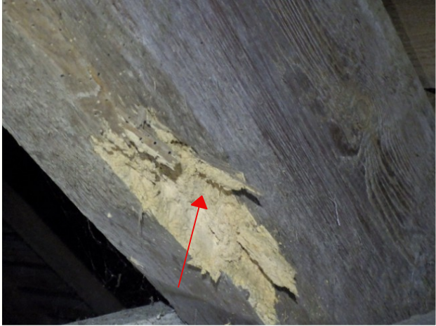
Ensemble - Aubier, bois réduit de section
