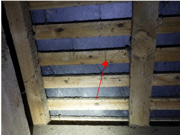
Charpente - Epaulement des ardoises dans le plan carré
