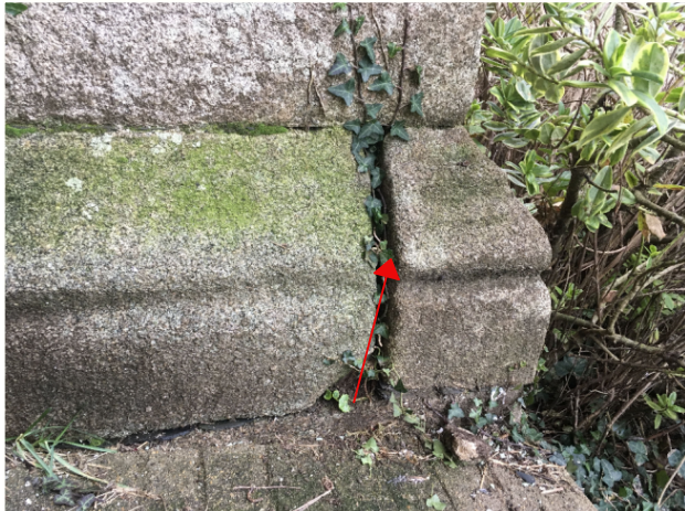
Élévation ouest - Joint creux
