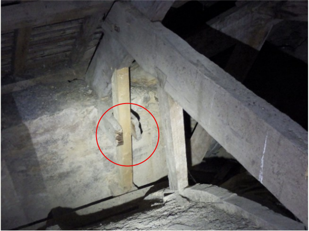
Nef - Eclatement blochet, réparation jambe de force
