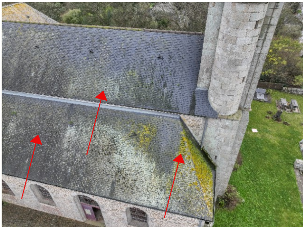
Élévation nord - Colonisation végétale importante
