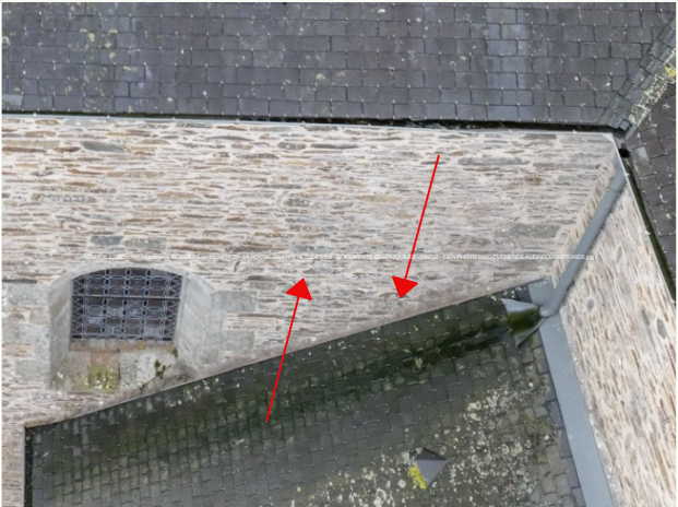
Élévation nord - Exemple solin ciment
