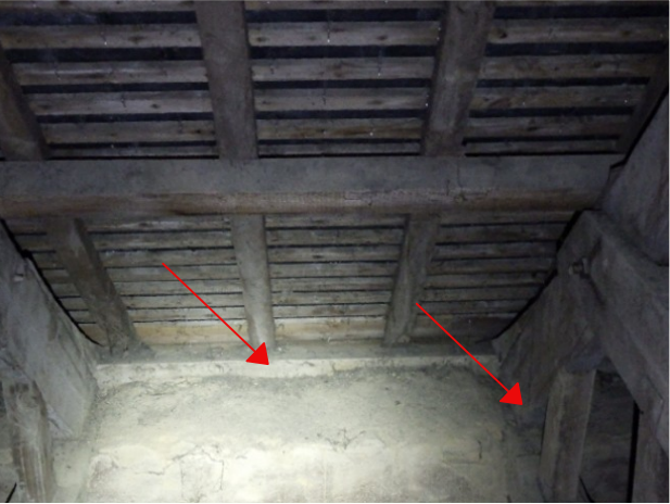
Ensemble - Bois noyés dans la maçonnerie
