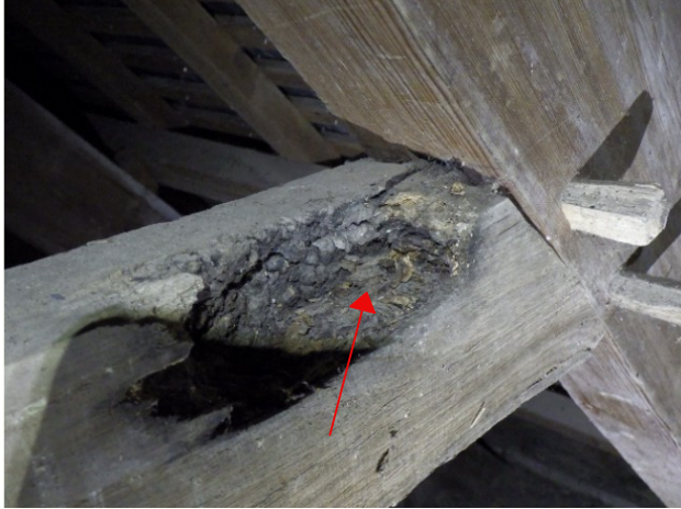
Nef - Altération entrain, section réduite
