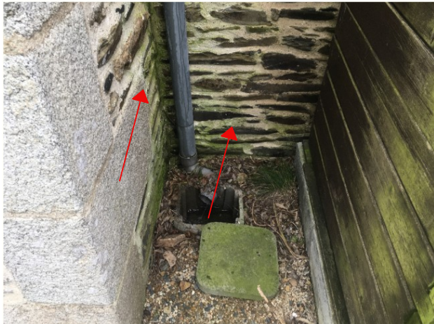
Élévation sud - Verdissement des maçonneries
