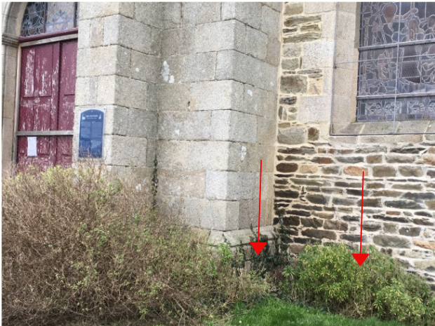
Élévation ouest - Végétation en pieds de mur
