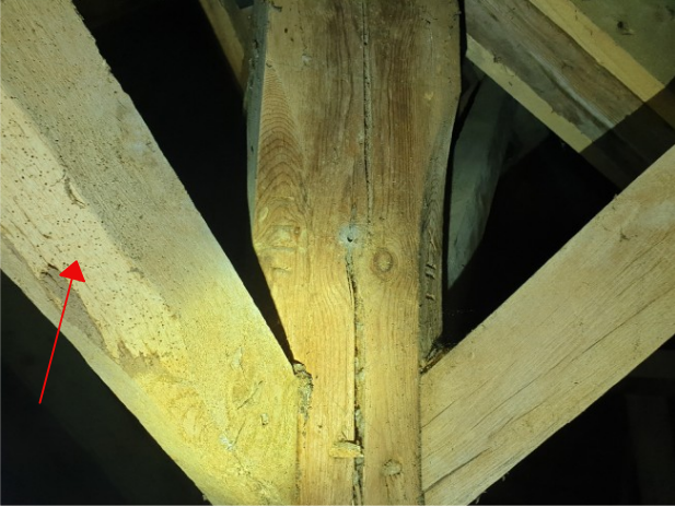
Ensemble - Vrilette, trous d'envol
