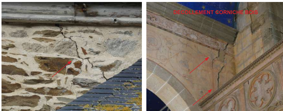
Fissures traversantes sur le mur gouttereau du bas côté Sud au droit du clocher.
