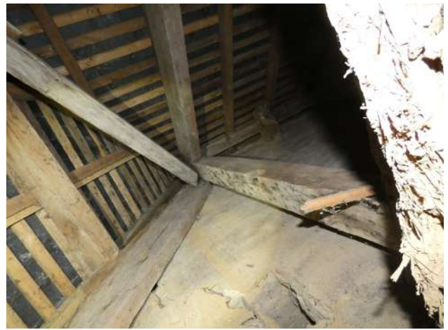
Vue sur le mur gouttereau (côté nef) et bas de versant montrant de l'humidité sur les liteaux.
