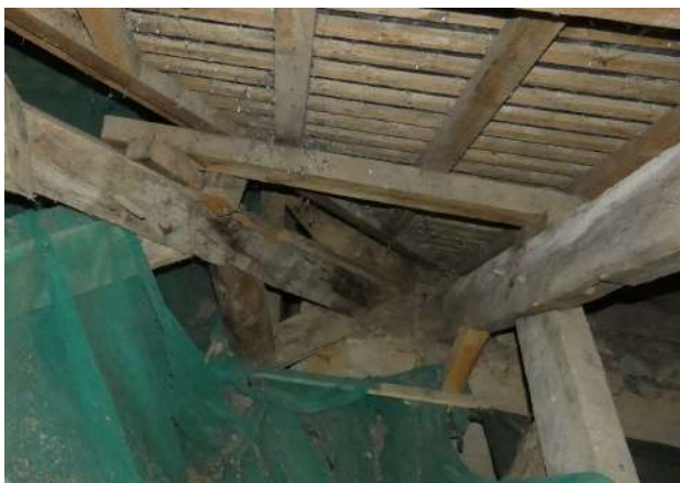
About de panne intermédiaire dégradée et simplement posée dans un ancien empochement.
