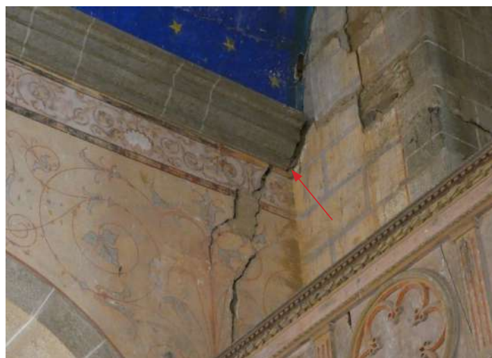
Joint entre deux éléments bois de la corniche, positionné entre deux faux joints peints.
