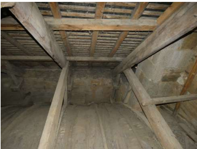
Contrefort du clocher en pierre de taille et maçonnerie de moellons et vue sur les arases et tête des murs gouttereaux.
