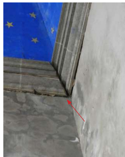
Enduit fausse pierre sur l'arc diaphragme et donnant l'illusion d'arc en pierre de taille et voûte maçonnée.
