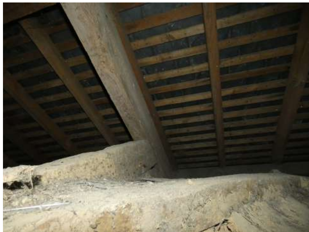
Vue sur le mur gouttereau (côté nef) et bas de versant montrant de l'humidité sur les liteaux.
