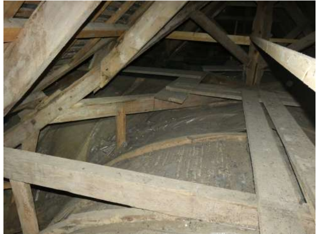
Jonction de la croisée avec poinçon central et enrayure basse se connectant sur les quatre arbalétriers des noues.
