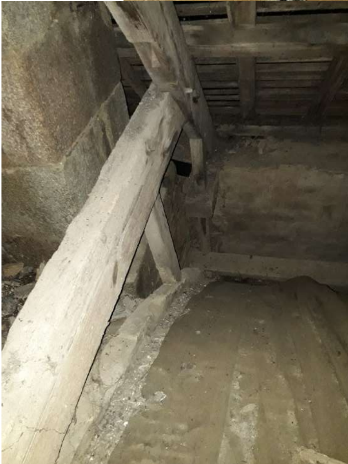
Panne en bois massif pourrie et non ancrée dans le mur. Traces d'humidité dans les murs. Traces des ruissellement d'eaux dans les éléments de charpente.
