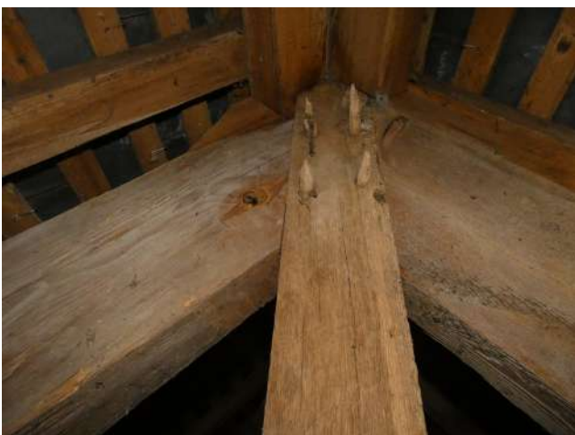
Tête du poinçon avec assemblage à tenon mortaise et cheville chêne surportant une double panne faitière et trace de marquage lors du taillage en atelier et du montage in-situ.
