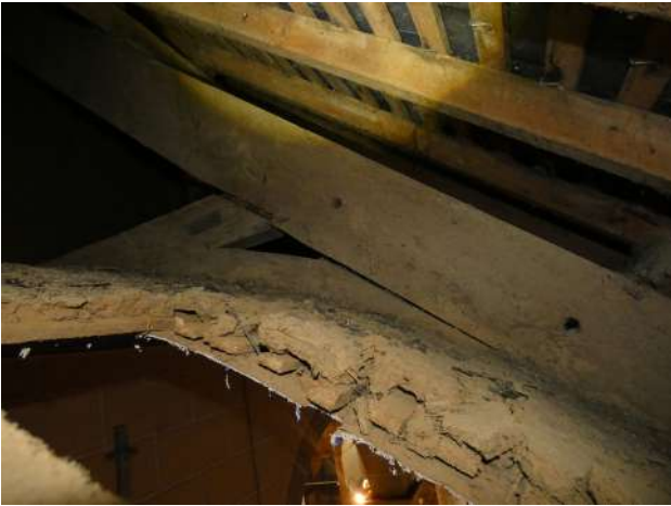
Vue en écorché de la composition de la voûte et extrados en terre.
