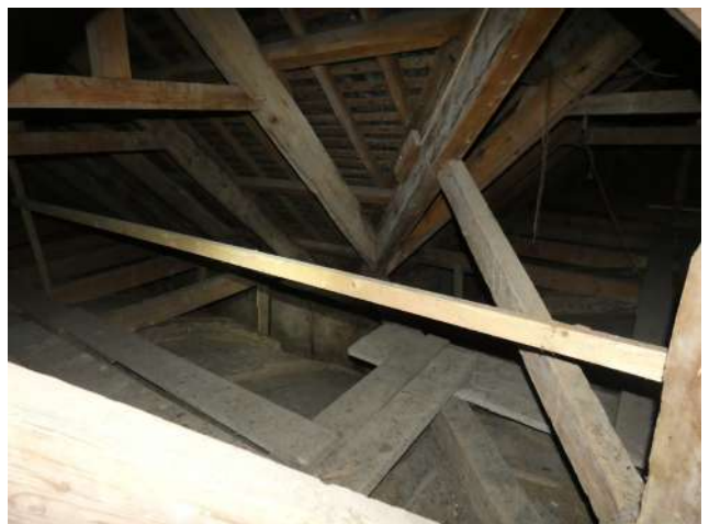
Détail des aiguilles avec assemblage à queue d'aronde sur l'entrait retroussé, permettant de suspendre les cerces (ossature) de la voûte en terre et lattis).
