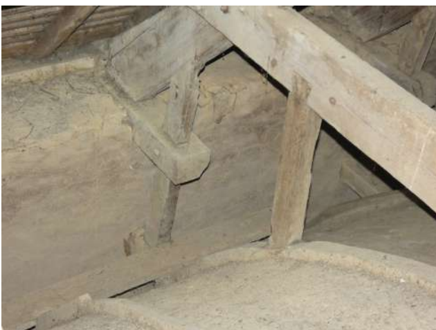
Détail des aiguilles avec assemblage à queue d'aronde sur l'entrait retroussé, permettant de suspendre les cerces (ossature) de la voûte en terre et lattis).
