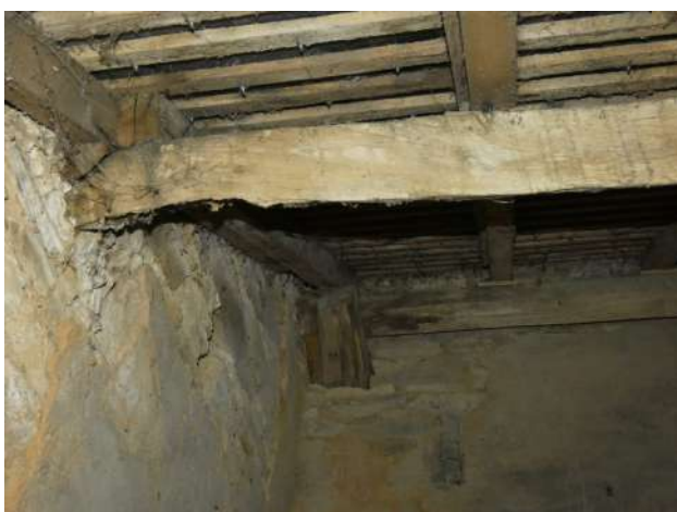
About de panne intermédiaire dégradée au droit de la jonction avec le bras Nord du Transept.
