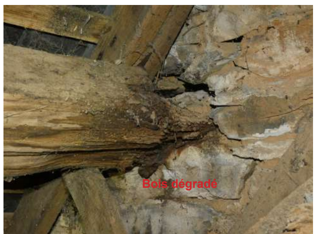
About de panne intermédiaire dégradée au droit de la jonction avec le bras Nord du Transept.
