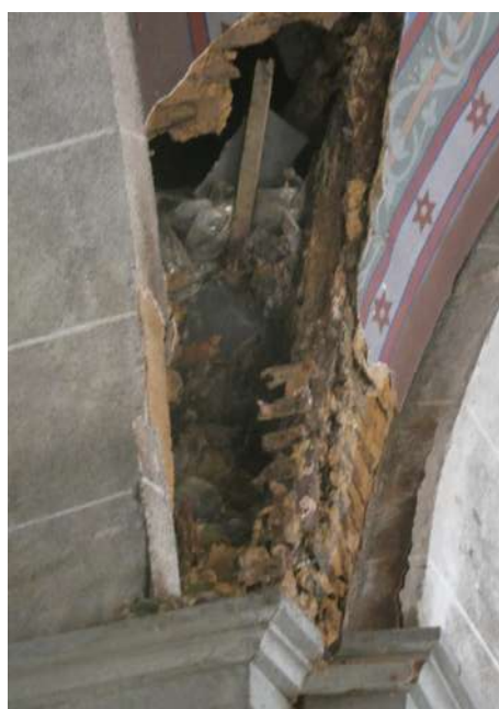
Pied de noue altéré.
