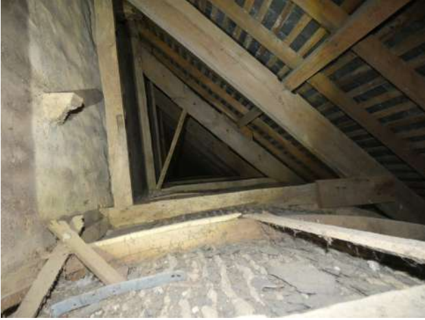
Demi ferme de charpente et ossature de voûte. / Vue de l'enduit terre fibré.
