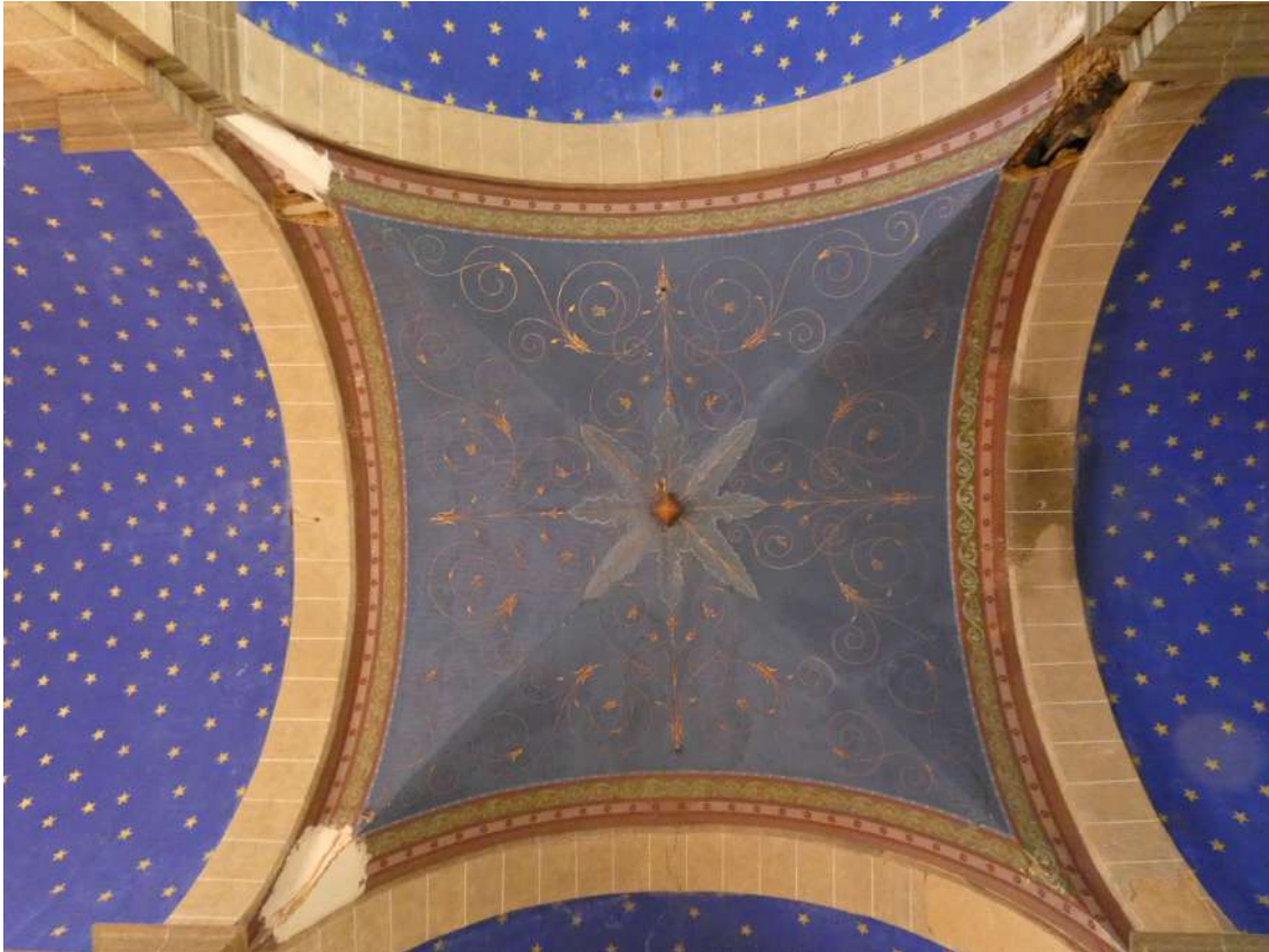
Arc en duit avec décors faux joints.
