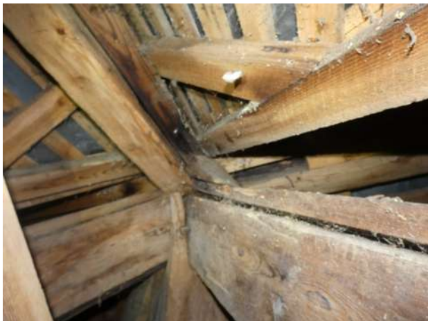
Présence d'infiltration au droit du poignon de la croisée et des pieds des noues.
