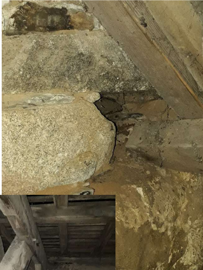
Panne en bois massif pourrie et non ancrée dans le mur. Traces d'humidité dans les murs. Traces des ruissellement d'eaux dans les éléments de charpente.
