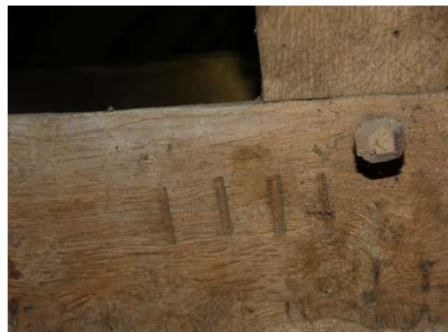
Tête du poinçon avec assemblage à tenon mortaise et cheville chêne surportant une double panne faitière et trace de marquage lors du taillage en atelier et du montage in-situ.
