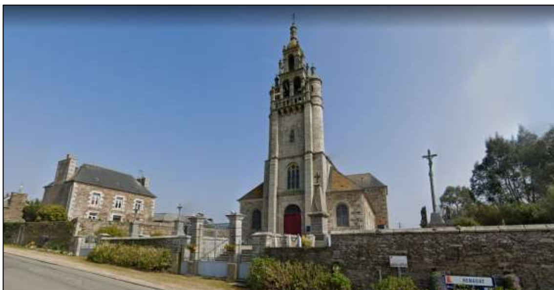
Le soutènement bordant la RD à l'Ouest de l'édifice traduit un terrain d'origine plus haut au Nord qu'au Sud
