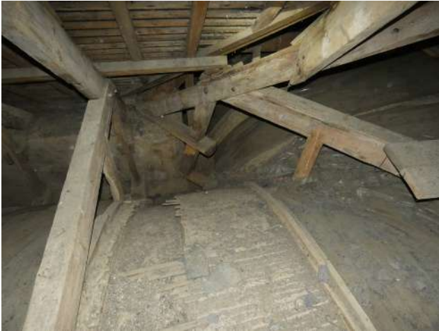
Jonction de la croisée avec poinçon central et enrayure basse se connectant sur les quatre arbalétriers des noues.
