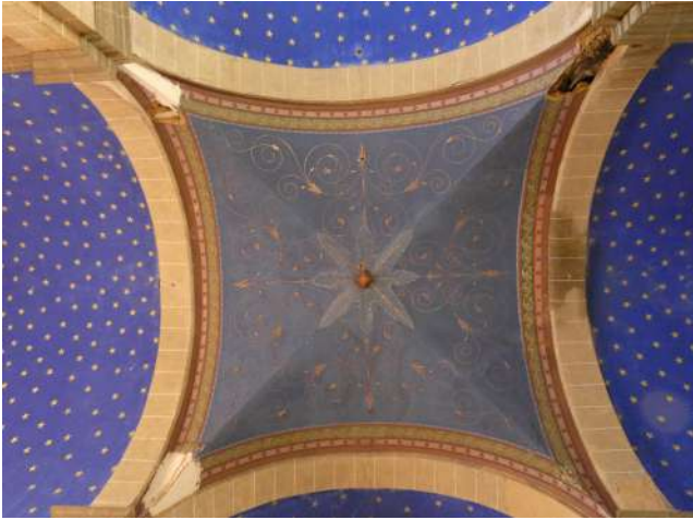
Vue de la voûte à croisée d'ogive et des arcs
