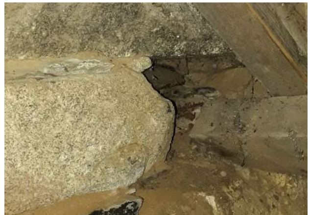
About de panne intermédiaire dégradée et simplement posée dans un ancien empochement.
