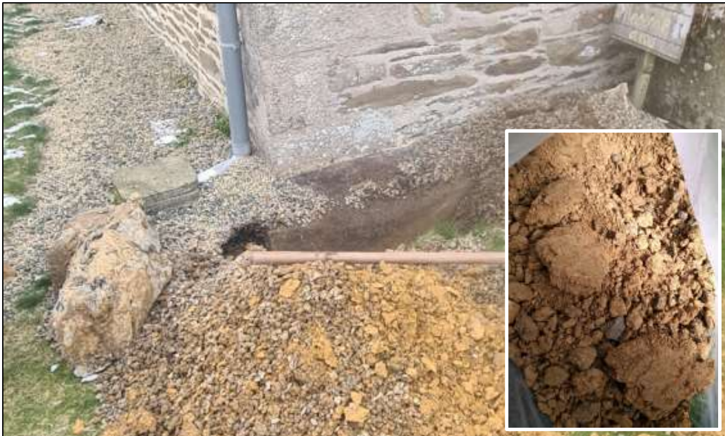
Situation du sondage RF5 et cuttings prélevés en sous-face de fondation
