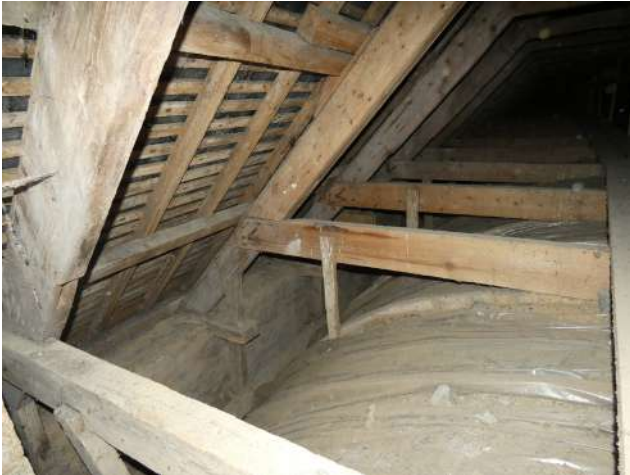
Vue depuis le passage du clocher sur le volume de la nef.
