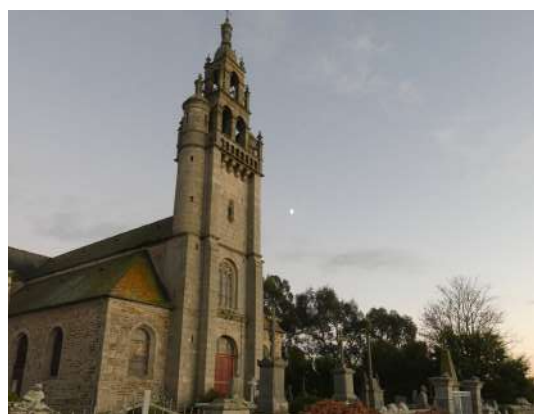
Eglise vue depuis le pont de Grez-Neuville Source : XV41 Architecte
