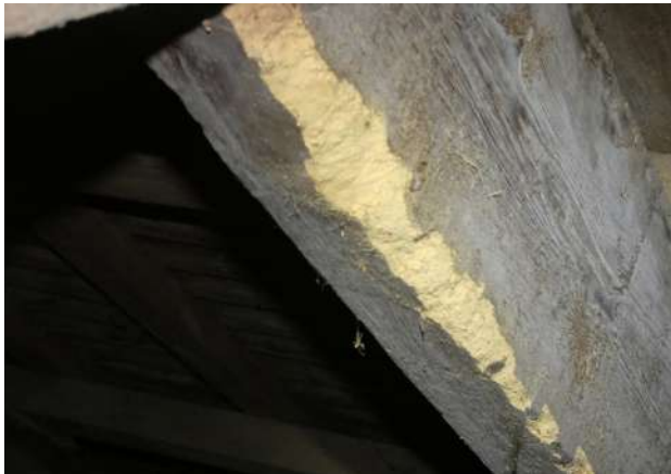
Présence d'attaque xylophage (actif car nous observons de la sciure).
