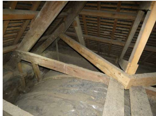
Jonction de la croisée avec poinçon central et enrayure basse se connectant sur les quatre arbalétriers des noues.
