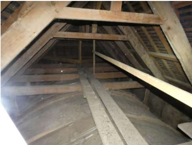
Au niveau du chœur, vue sur la ferme de croupe et des arrêtières.
