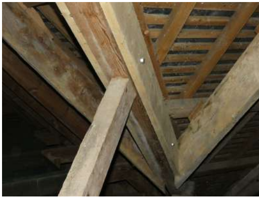
Renforcement par moisage boulonné de la noue.
