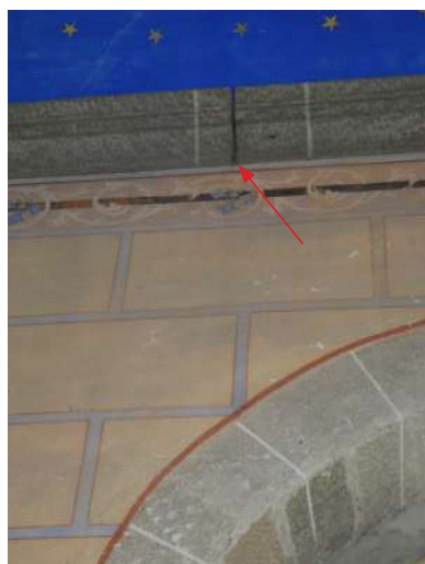
Joint entre deux éléments bois de la corniche, positionné entre deux faux joints peints.
